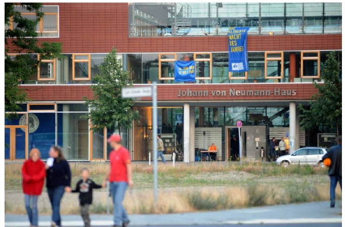
Unser Institutsgebäude vor der Langen Nacht © David Ausserhofer
